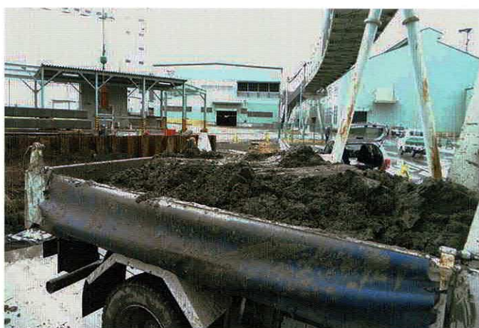
ダンプ積み込み完了
