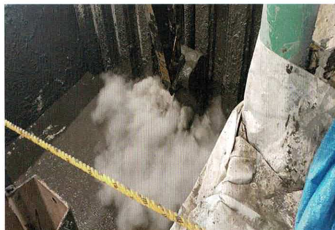
セメント系固化材 添加・混合
