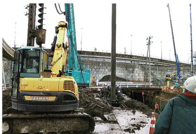
杭打設位置調整
