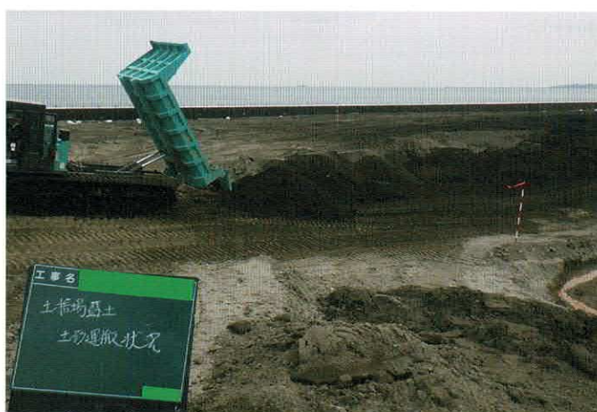
改良後運搬状況
