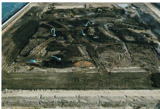
着工時現場状況
