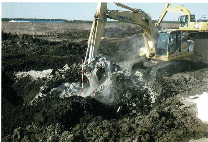
セメント改良状況
