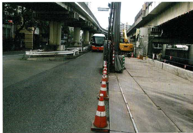
狭小な現場状況
