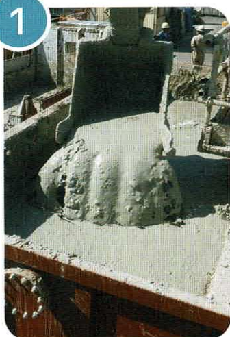
高含水泥土発生
