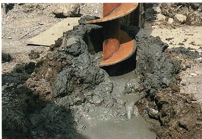
高含水泥土発生
