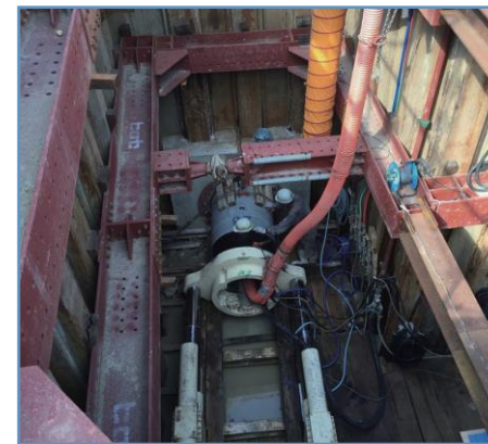
推进·盾构多余泥浆
